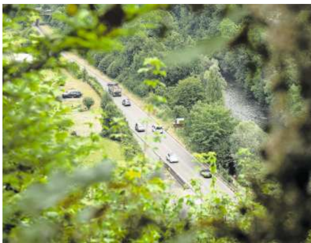
Ein Wald schützt die Strasse in Angenstein vor Felsbrocken.
